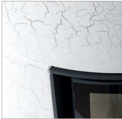
Wärmebetonanstrich weiß krakeliert
